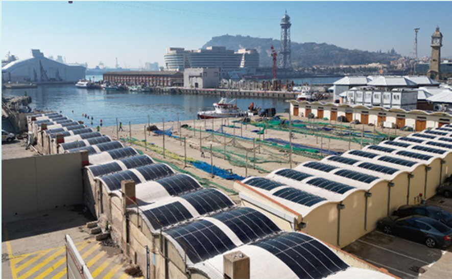
Instalación de paneles solares flexibles (ondulados) en el Puerto de Barcelona. Imagen tomada de www.heliatek.com
